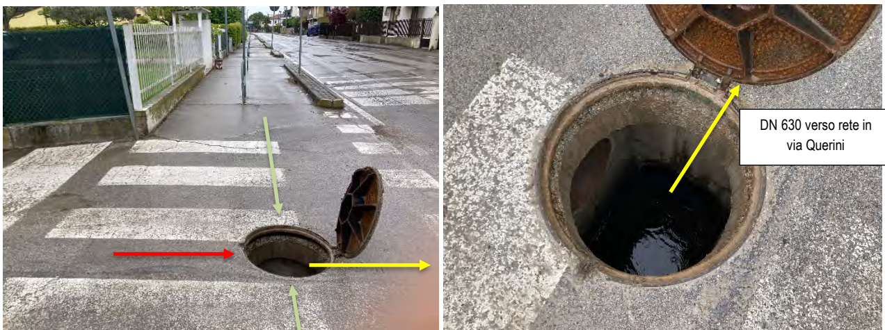
Foto 2: pozzetto rete mista in via Querini
